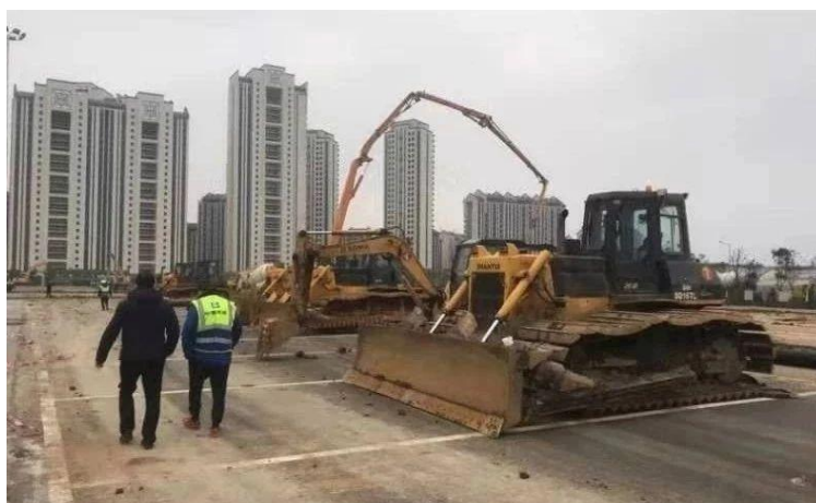
武汉火神山医院建设现场
